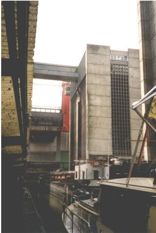
Dort wartet das Schiffshebewerk Scharnebeck auf uns. Für Liberty ist es das 3. Hebewerk auf dieser Reise. Mit 38 m Hub ist es das größte.
